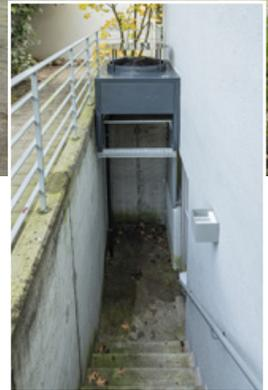
*Schwabender Einbau der Ausseneinheit beim Kellereingang, Heizungskeller mit Heizungspeicher und Wärmepumpenboiler.*
