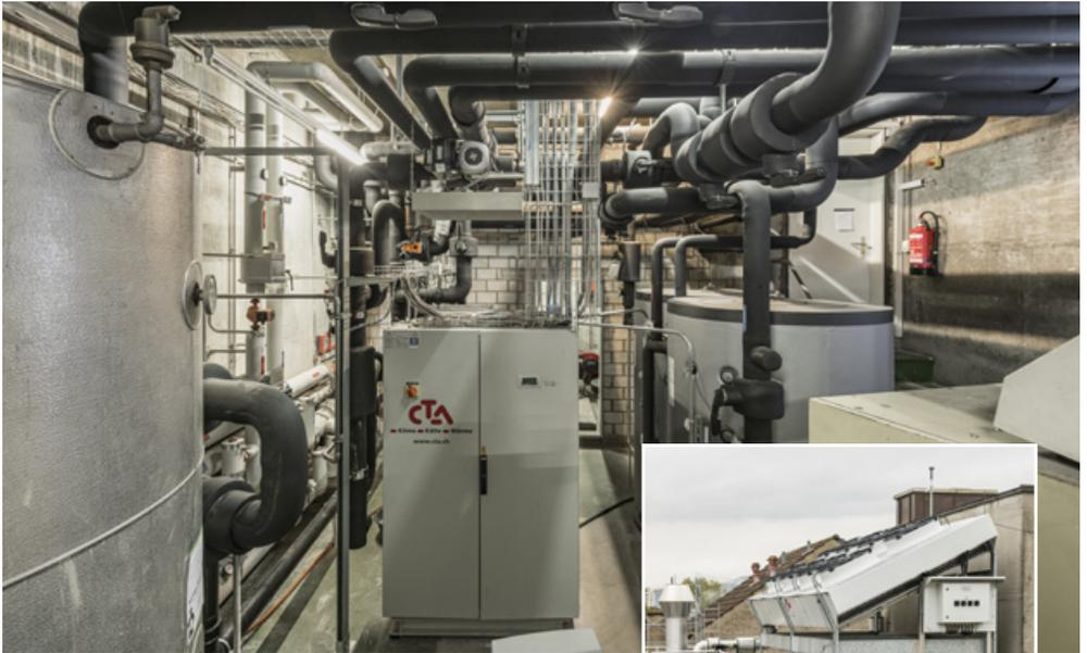
Wärmepumpe und Speicher im dritten Untergeschoss, Rückkühler auf dem Dach
