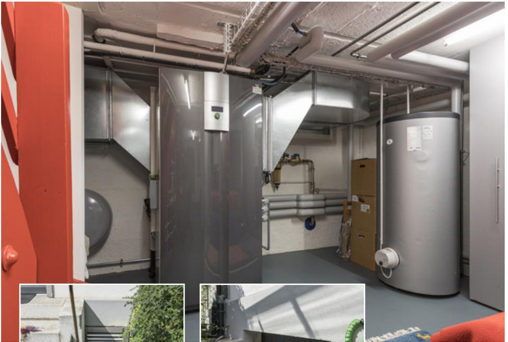
*Wärmepumpe im Keller, Ansaugöffnung neben dem Eingang (links), Ausblasen durch Kellerfenster (rechts).*
