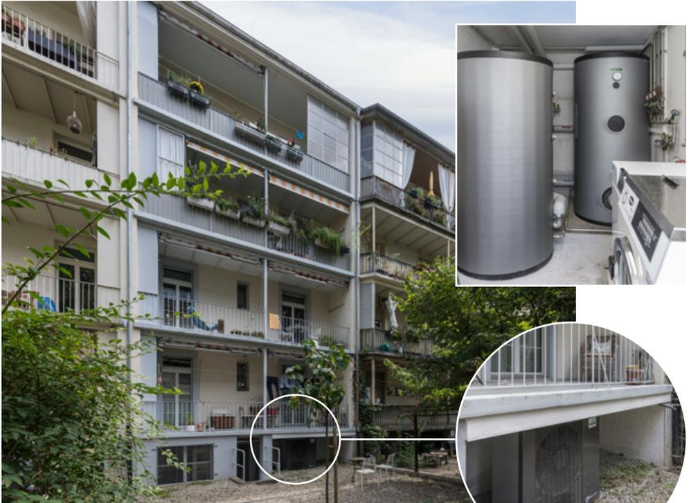
*Aussen aufgestellte Wärmepumpe unter dem von unten gedämmtem Erdgeschossbalkon.*
