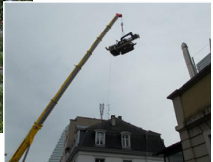
*Der Garten zwei Jahre nach Umsetzung, Wärmepumpe im Heizungskeller, Einbringen des Bohrgeräts über das Dach hinweg.*
