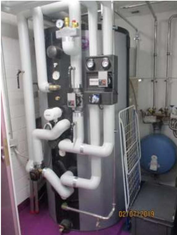
Abbildung 8: Speicherstutzen sind bis an die Speicherdämmung gut gedämmt. Die Wärmeverluste werden so niedrig gehalten.
