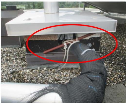
Abbildung 11: Die Solarleitung wurde, statt mit Rohrschellen, mit einem Stock und einem Seil am Kamin gesichert.
