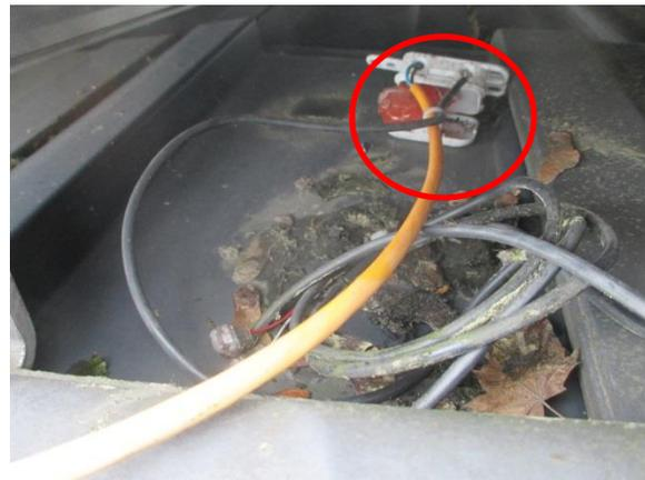
Abbildung 10: Unsauber verlegtes Fühlerkabel. Es wurde zwischen Dach und Kollektor verstaut und die Verbindungsbox ist offen. Ein Ausfall des Kollektorfühlers ist so vorprogrammiert.
