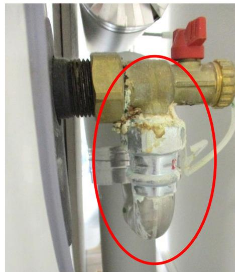
Abbildung 12: Verzinkte Leitungen im Solarkreis verursachen elektrochemische Korrosion und müssen spätestens bei einer Leckage ersetzt werden.
