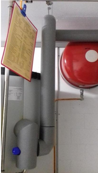
Abbildung 5: Der Warmwasserabgang wurde siphoniert ausgeführt und der Thermomischer wurde vom Installateur in die Dämmung integriert. Durch diese relativ kleine Massnahme reduzieren sich die Speicherverluste erheblich. Auch ist die Anlagedokumentation ist gut sichtbar angebracht.
