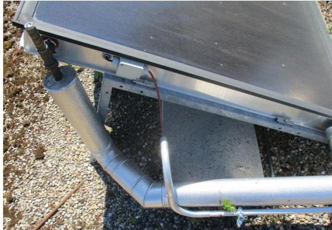
Abbildung 6: Fachtechnisch einwandfrei verlegte Solarleitung mit witterungsgeschützter Dämmung. Auch das Fühlerkabel ist gegen Tierfrass geschützt und hängt nicht lose im Raum.
