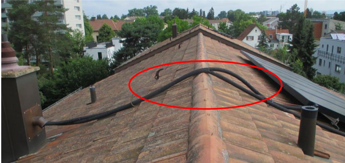
Abbildung 14: Eine über den Dachgiebel horizontal verlegte Solarleitung aus Edelstahlwellrohr verursacht häufig einen unerkannten Anlagestillstand auf Grund Luftansammlung am höchsten Punkt des Solarkreises.
