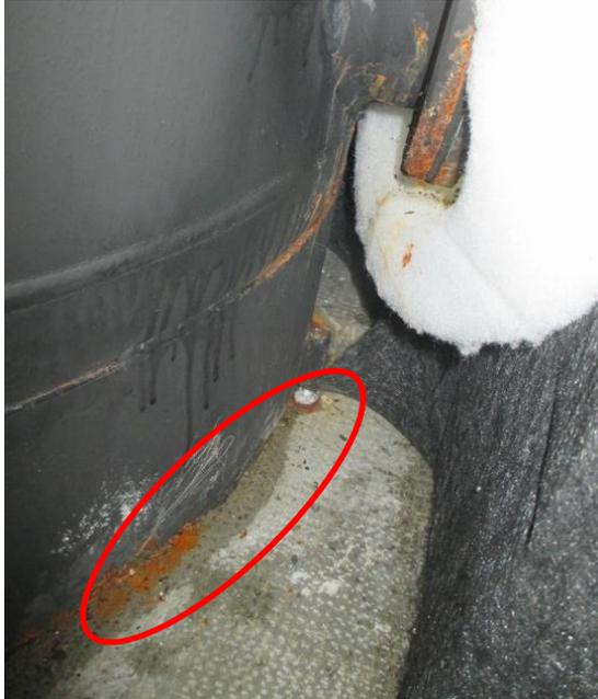
Abbildung 9: Leckage am Speicherflansch. Der Speicher zeigt nach zwei Betriebsjahren bereits deutliche Korrosionsspuren auf Grund der Leckage.
