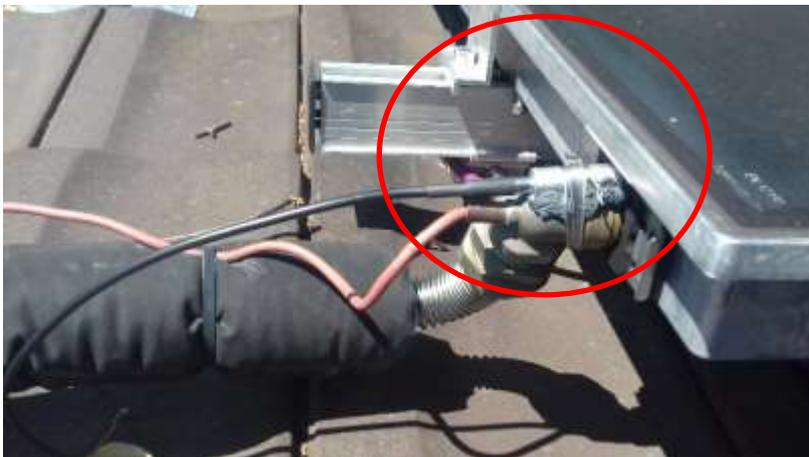
Abbildung 13: Der Kollektorfühler wurde bei der Begehung eingesteckt, gesichert und mit einem LoRaWAN-Funksensor ausgestattet, um die richtige Anlagefunktion zu überwachen.
